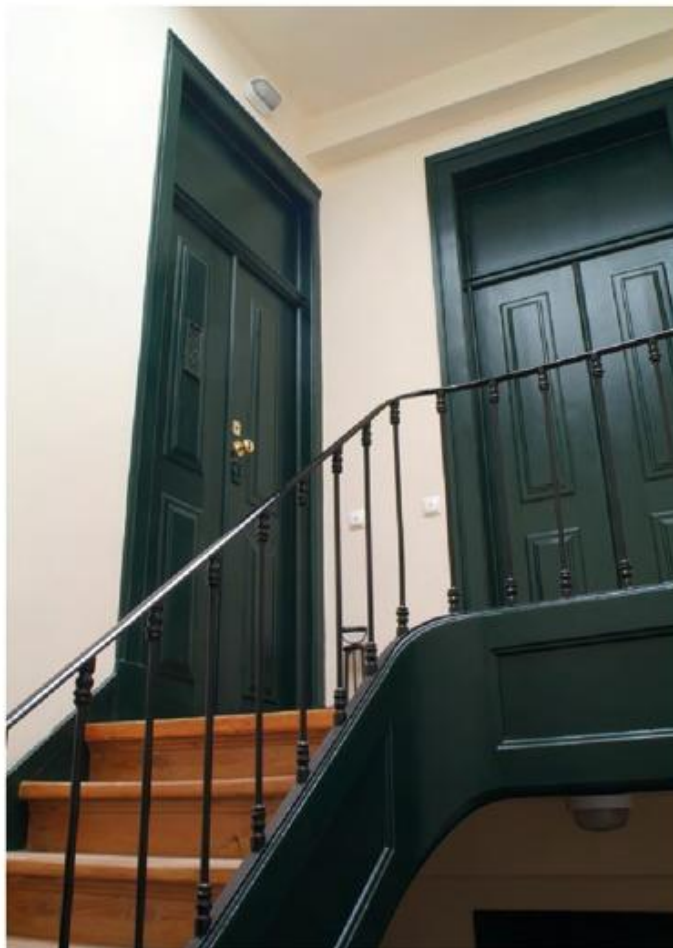
Caixa de escadas.
