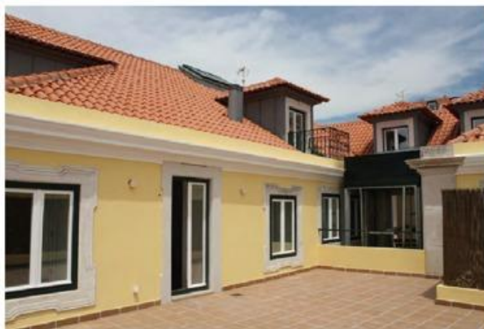
Terraço antes da intervenção. Terraço após a intervenção.
