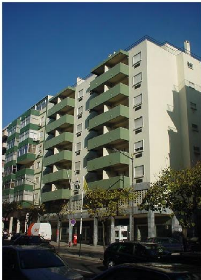
Edifício de escritórios existente.
