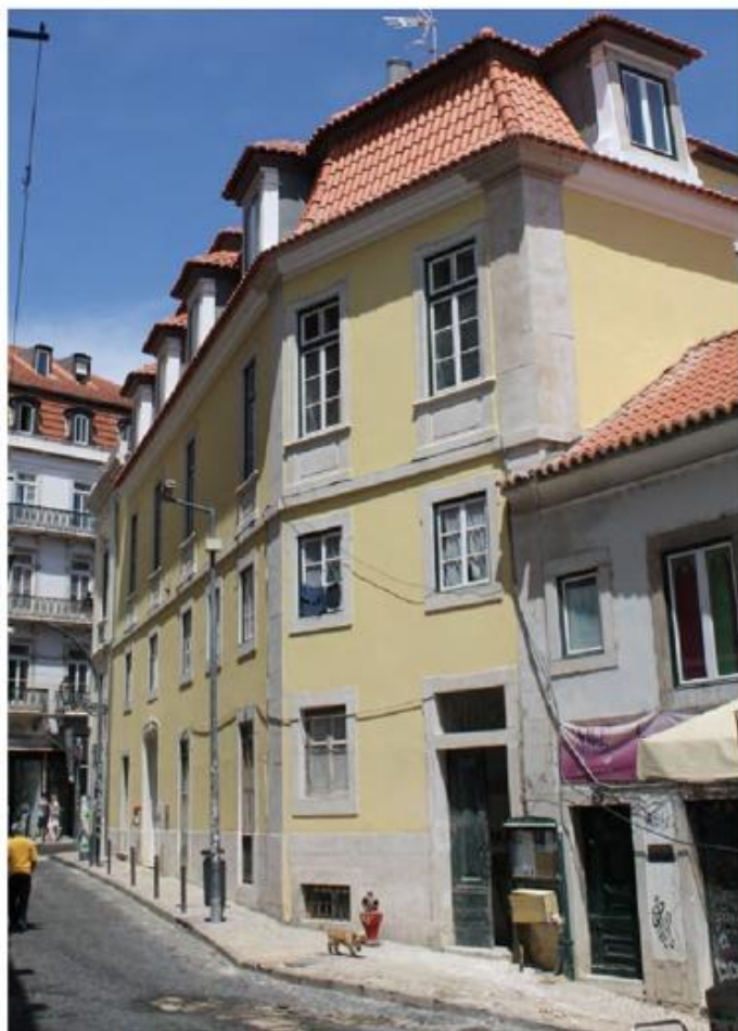
Fachadas laterais após intervenção.
