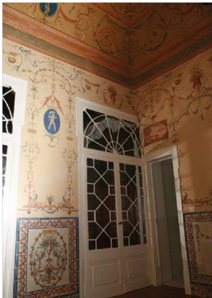
Pintura decorativa e painéis de azulejos após reabilitação, Palacete Vilhena.
