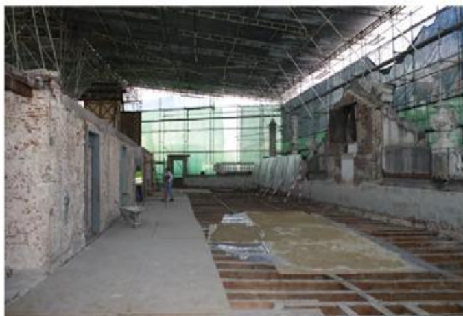
Fotografia das coberturas após intervenção.
